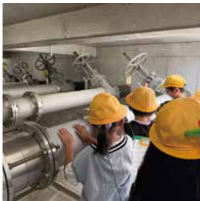
水道管に触れてみると「冷たい」
