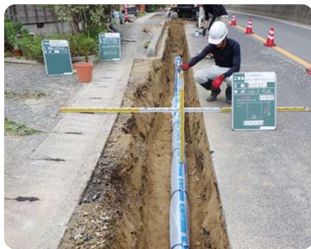
▲当組合での工事の様子
