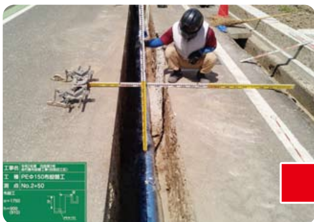
▲道路を掘って入れ替えます
