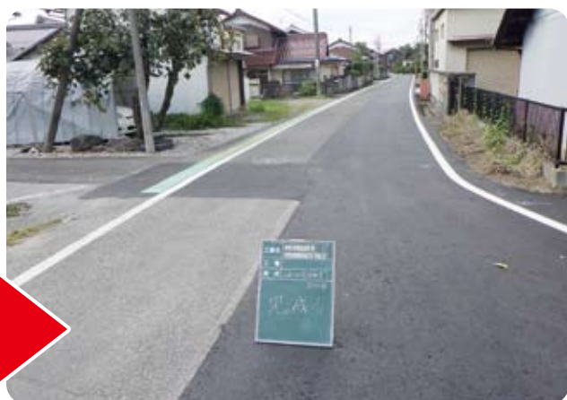
▲全て工事が完了
