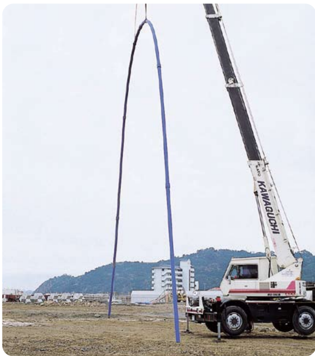
▲ポリエチレン管の強度テストをしている様子
