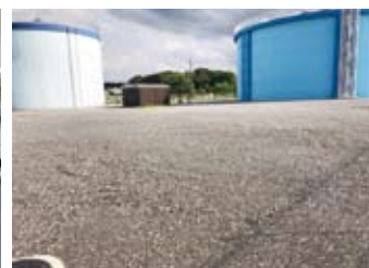
▲解体後の低区配水池
