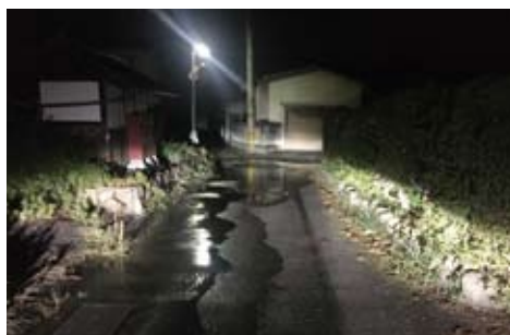
老朽化により漏水が発生しますが、修繕のみで更新ができません。
