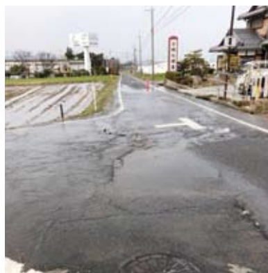
老朽化により漏水が発生しますが、修繕のみで更新ができません。
