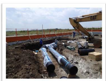
耐震管の布設
