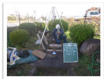
井戸カメラ調査 (水中ＴＶカメラ調査状況)
