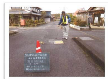
探知機による漏水調査
