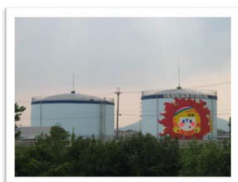
現在の低区配水池
