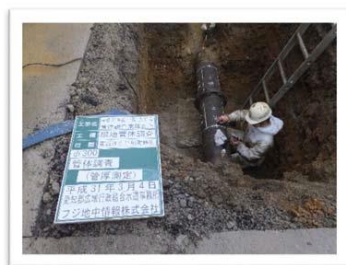
管体調査（管厚測定）
