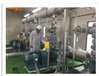
施設点検 (送水ポンプ点検)
