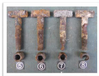
管体調査（ボルトナットの腐食状態）
