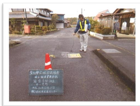
探知機による漏水調査
