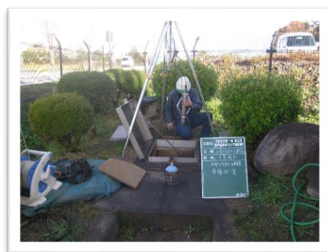
井戸カメラ調査 (水中 TV カメラ調査状況)
