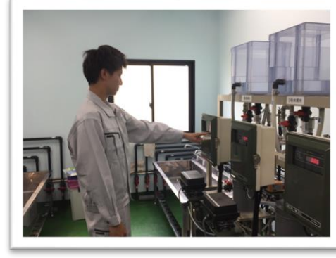
施設点検 (濁度点検)
