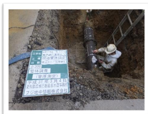
管体調査（管厚測定）
