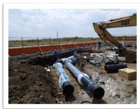
耐震管の布設
