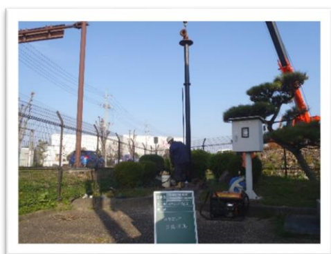
井戸カメラ調査 (揚水管引き上げ状況)
